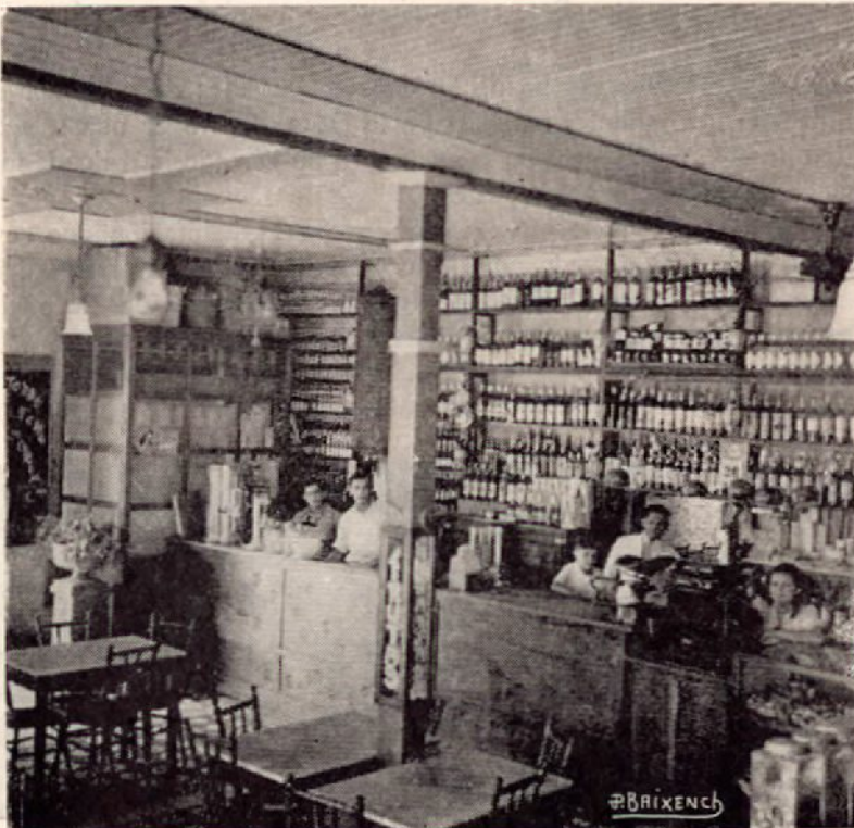
Sección interior del Salón "Petit Trianon"
